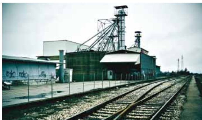
Sopra Il raccordo ferroviario interno all'azienda con cui arrivano i quarzi silicei
